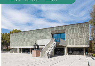
建物・設備の整備
